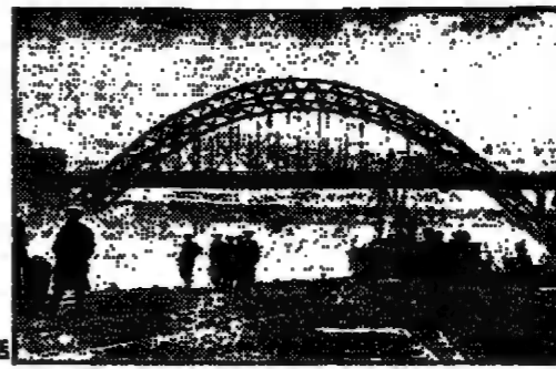
Tyne Bridge 1936 par Humphrey Spender.
